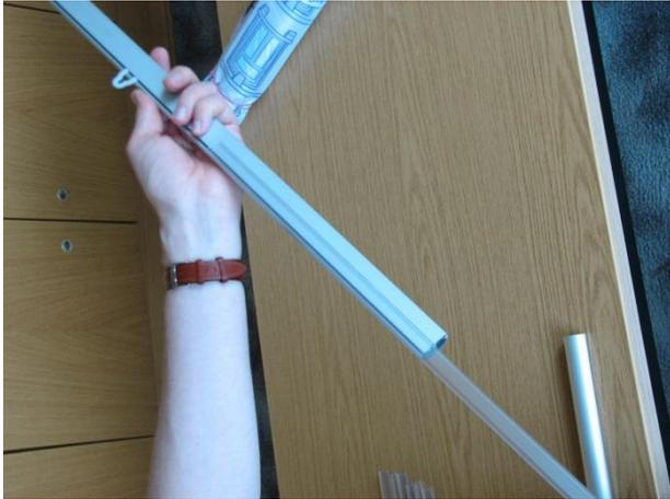
Die andere Hälfte des Verbinders kommt in die nächste Schiene. Jeweils vier Schienen oben (mit Haken) und unten (ohne Haken) werden auf diese Weise zusammengesteckt. Die Schienen mit Endkappen kommen nach außen.
